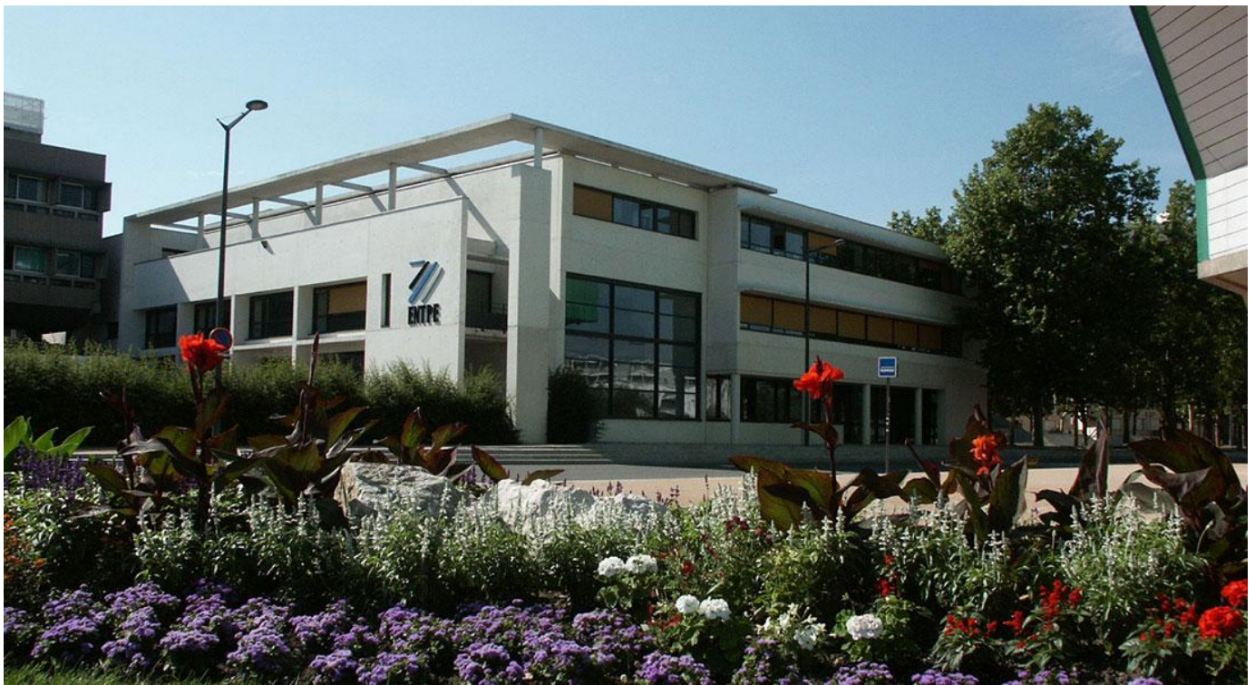
Bâtiment principal de l'ENTPE
