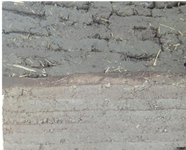
**La technique du pisé** qui consiste à construire des murs massifs en compactant de fines couches de terre humide dans des coffrages. Le mur est décoffré immédiatement après que la terre a été damée.
