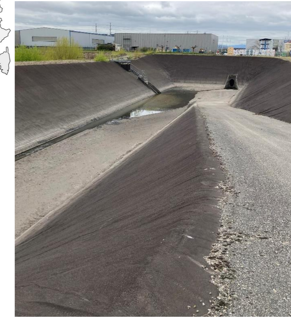
Bassin de rétention Leopha
