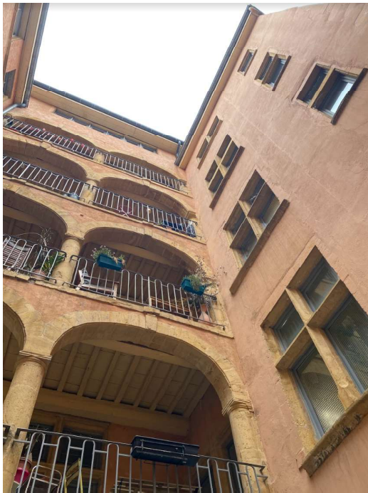
Figure 1 : Galerie sur cour situé au 22 rue Juiverie, dans le 5e arrondissement de Lyon
