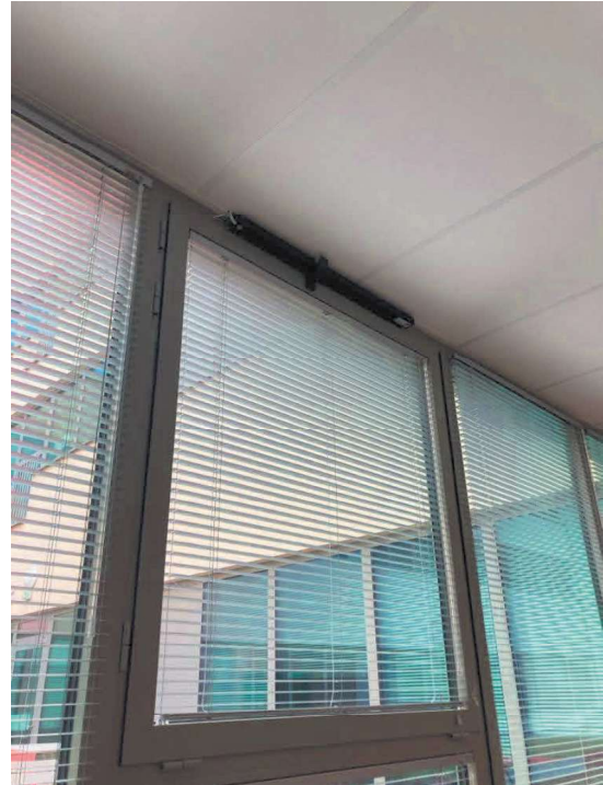
Figure 31 - Châssis avec un dispositif de free-cooling
