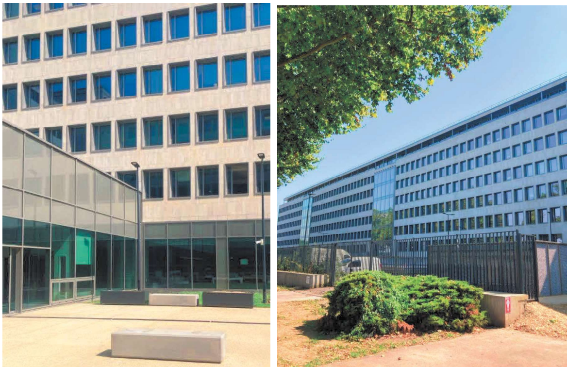
Figure 30 - Murs rideaux (Façade Ouest à gauche, Façade Nord à droite)
